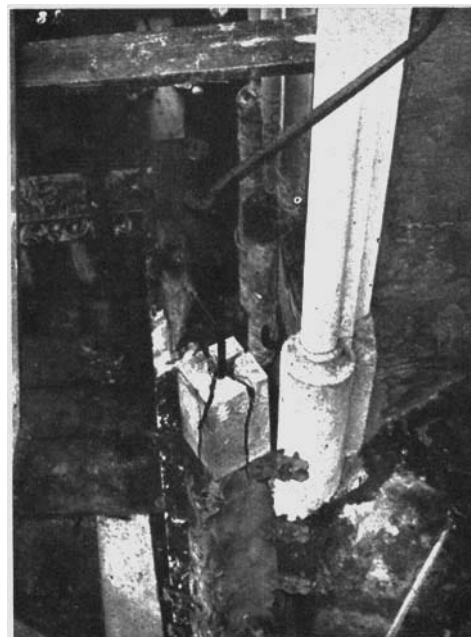
Abb. 9. Sprengung durch Rosten (1880) einzementierter Eisen- dübel sowohl des neu versetzten wie des alten Gesteinsmaterials.
