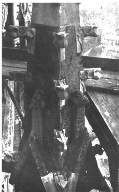
Abb. 6. Verwitterungsbeschleunigung durch teilweisen Materialersatz.
