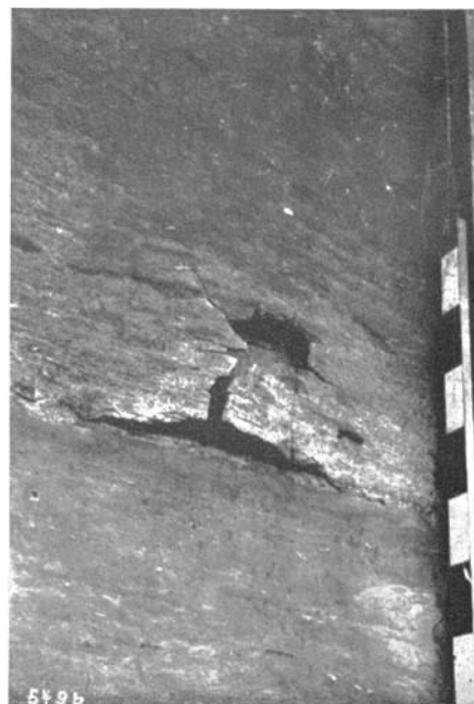
Abb. 4. Durch Sulfatsprengung aufgeplatzte Schale an einem Quader aus Glaukonitsandstein (Regensburger Dom).
