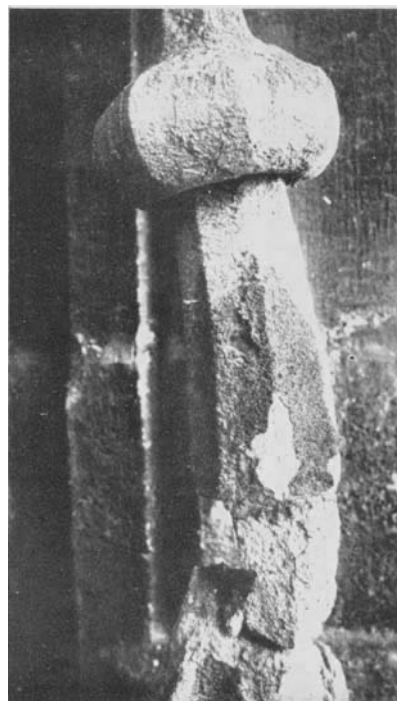
Abb. 7. Zwiebel aus Glaukonitsandstein. Bekannte Erscheinung des Krummziehens nach der bevorzugt austrocknenden Seite infolge Anreicherung von Salzen.
