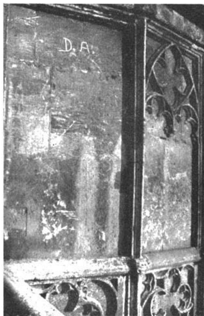
Abb. 1. Mehligte Verwitterung vom Regensburger Dom (Westfassade).
